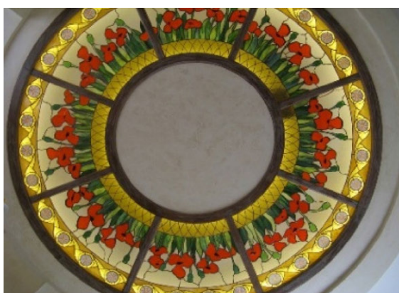
Рис. 2. Деревянная несущая конструкция потолка под «Маки»
