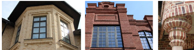
Рис. 2. Архитектурные элементы фасада, выполненные из полнотелого кирпича мягкой формовки
