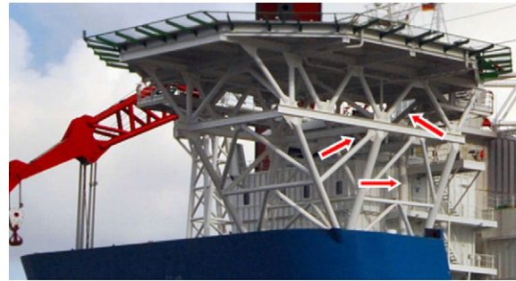
Рис. 13. Укрепление конструкции вертолетной площадки за счет установки трех дополнительных трубных опор (показаны стрелками)
