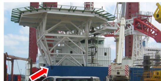
Рис. 14. Общий вид вертолетной площадки. Стрелкой показано место коллизии (пересечения) трубных опорных конструкций площадки и конструкций фальшборта судна
